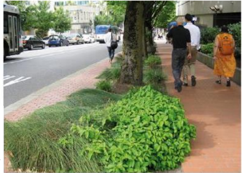
Tranchée continue recueillant les eaux pluviales, Portland
